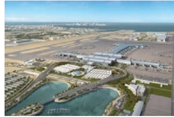
Nouvel Aéroport International de Doha Doha / Qatar
